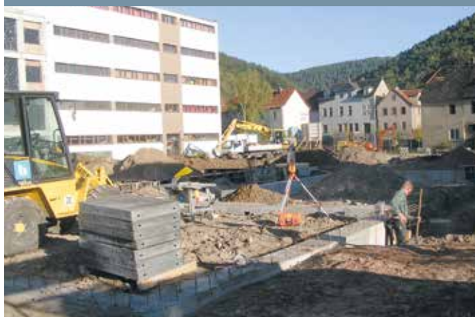
Am 9. September 2004 wird der Grundstein für eine offene Ganztagschule in Uhlstädt gelegt. Die Bundesregierung hatte 2002 ein Investitionsprogramm zur Förderung dieser Schulform aufgelegt. Das alte Schulgebäude wird abgerissen. (Foto: Archiv Landratsamt)
