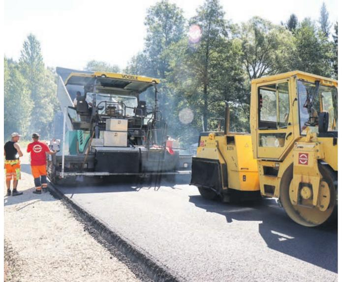
Eine schweißtreibende Tätigkeit war die Verarbeitung des mit 170 Grad Celsius angelieferten Materials für die Mitarbeiter der Firma Streicher aus Jena. Bei über 30 Grad Außentemperaturen mussten sie so mit Hitze von unten und oben kämpfen. (Foto: P. Lahann)
