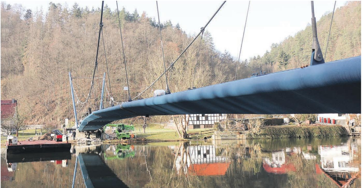
Dass die Stahlkonstruktion zwischen Obernitz und Reschwitz aus fünf Einzelteilen besteht, kann man hier schon nicht mehr erkennen. Im Bild spiegeln sich am jenseitigen Ufer die Häuser am Ortsausgang von Reschwitz, links ein Ponton für den Transport der Bauteile. (Foto: M. Modes)
