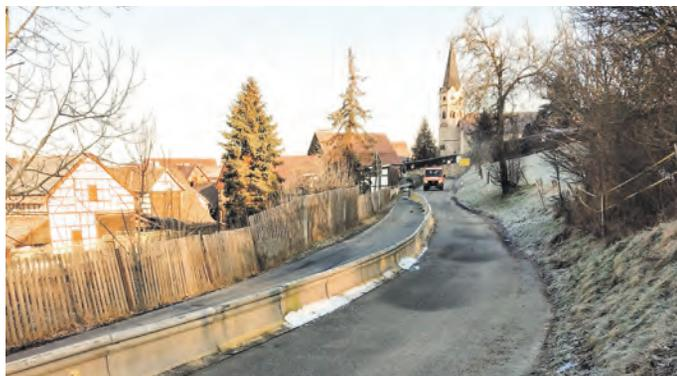
Die Stahlgleitwand an der Ortsverbindungsstraße der K126 zwischen Unter- und Oberpreilipp steht. Damit wird die Einspurigkeit hergestellt, da die Straße im Hangbereich geschädigt ist. Der Verkehr wird durch eine Ampel geregelt. (Foto: S. Ammon)
