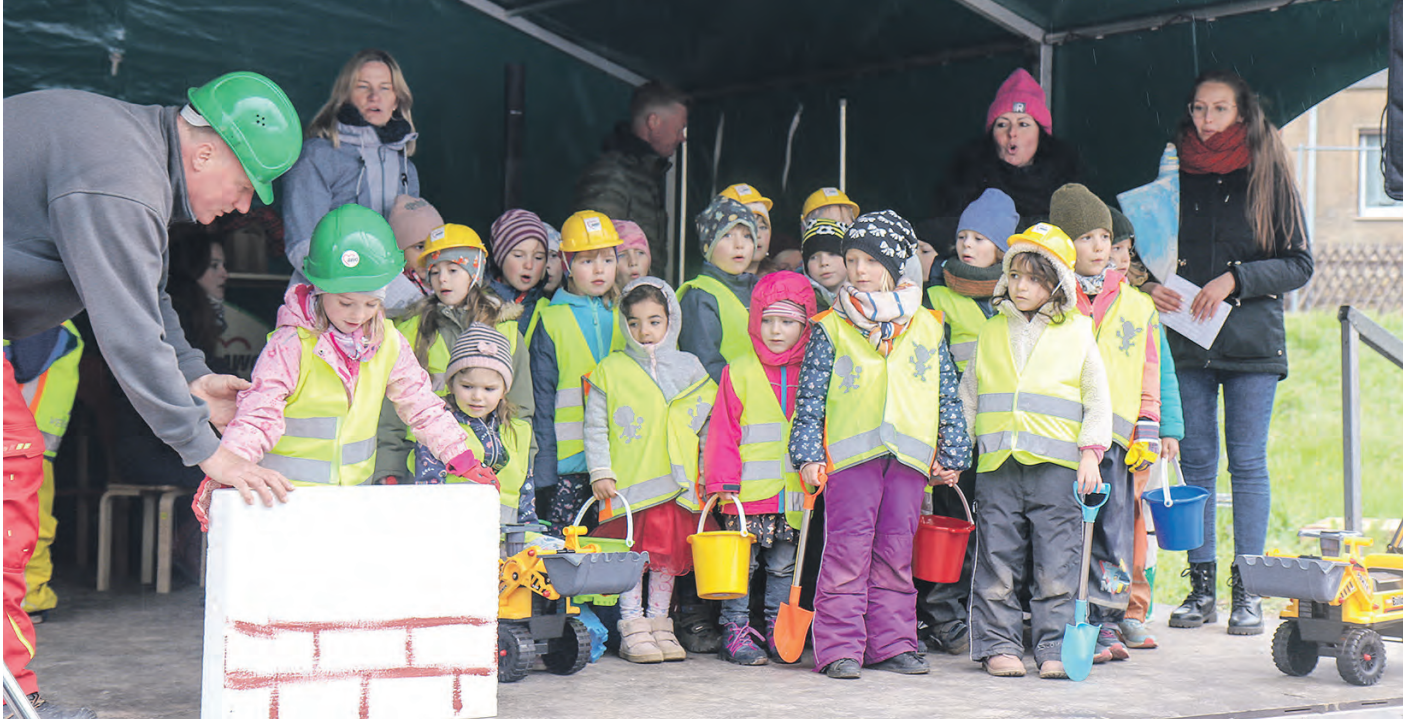
Am künftigen Kindergarten der Arbeiterwohlfahrt Saalfeld-Rudolstadt in der Garnsdorfer Straße in Saalfeld wurde am 19. April mit einem symbolischen ersten Spatenstich der Baubeginn gefeiert. Zur Begrüßung der Gäste boten Kinder aus anderen Kindergärten der AWO ein musikalisches Programm, bei dem schon mal ein Miniatur-Kindergarten auf der Bühne entstand. (Foto: Peter Lahann)
