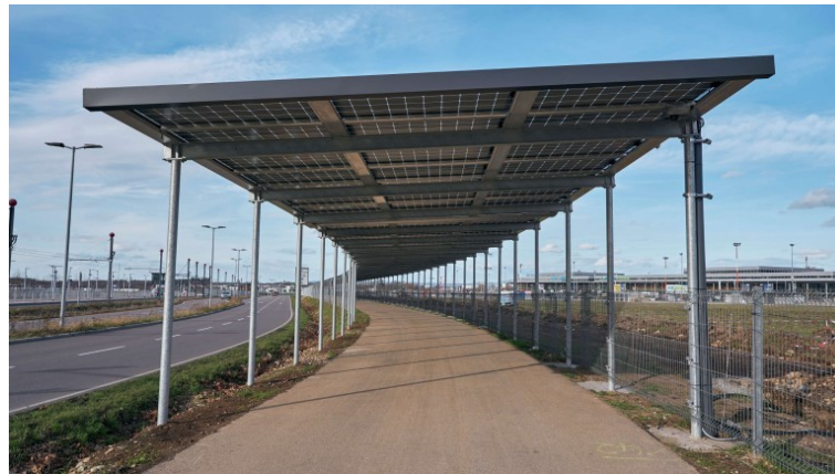
Abbildung: BadeNova Wärmeplus: Deutschlands erste Solar-Radwegüberdachung 2
