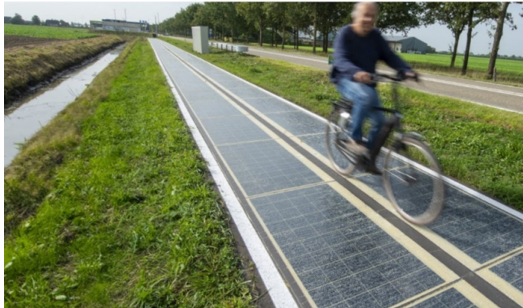
Abbildung: Radweg mit Wattway-Solarteilen in Bunnik, Niederlande 4
