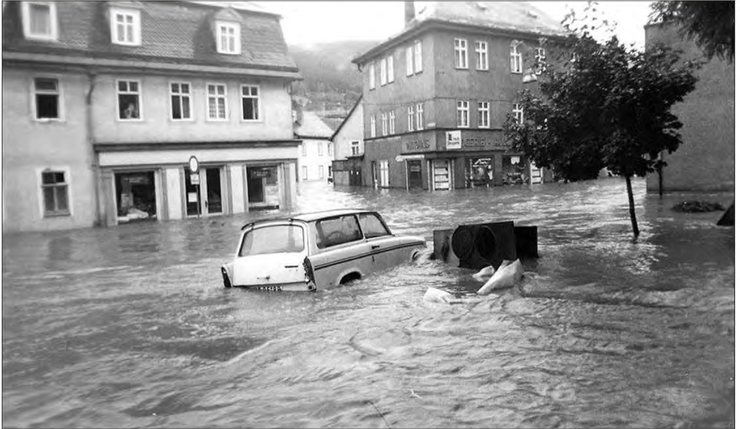
Bad Blankenburger Hochwasser am 10. und 11.08.1981 – Blick in die Untere Marktstraße
