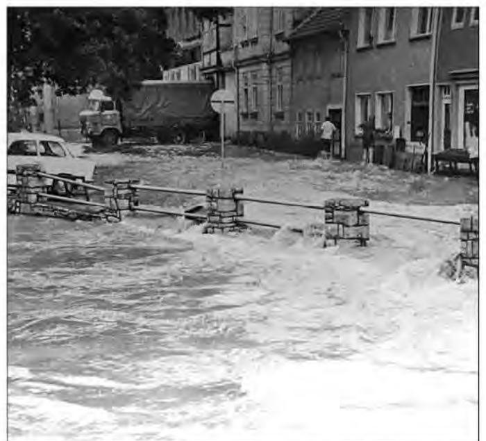
Bad Blankenburger Hochwasser am 10. und 11.08.1981 – An der Rinnebrücke „Dörfchen“.
