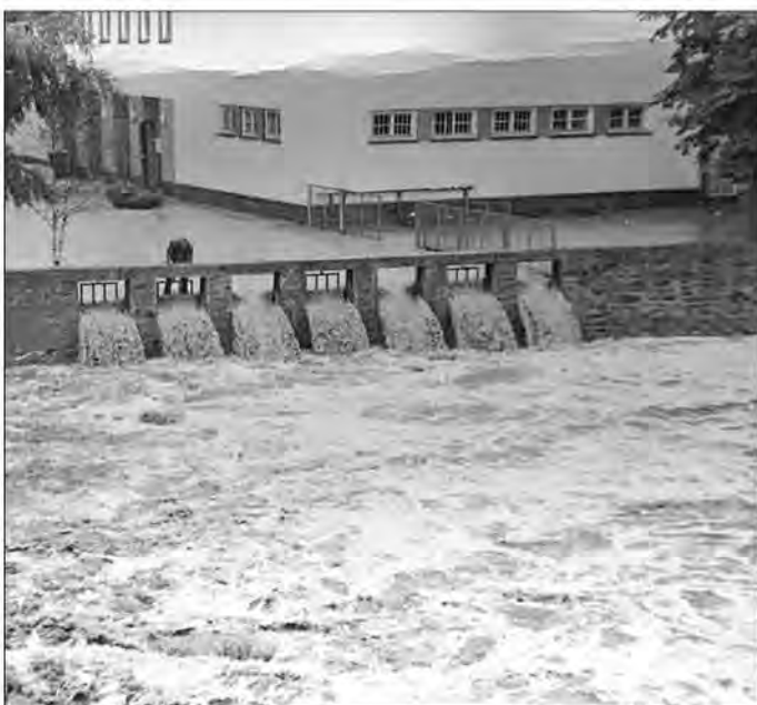
Bad Blankenburger Hochwasser am 10. und 11.08.1981 – An der Stadthalle.
